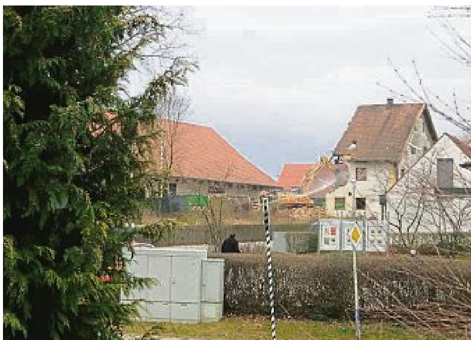
Musste weichen: Das alte Bruggerhaus wurde abgerissen.
