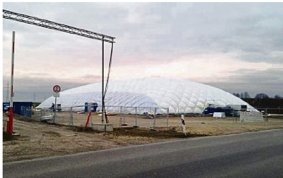
Raum für 300 Flüchtlinge: Die Traglufthalle beim GADA.
