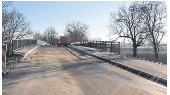
Brücke über die B 471.
