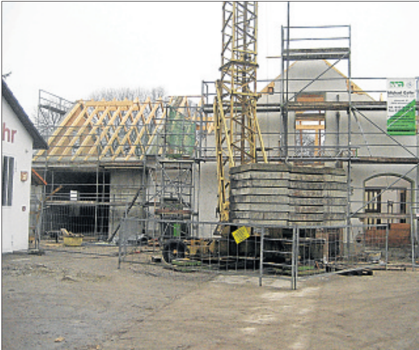
Umbau der alten Schule in Eschenried mit Neubau des Feuerwehrhauses.
