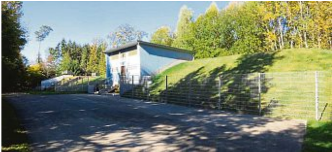
Der Hochbehälter im Wald bei Deutenhausen
