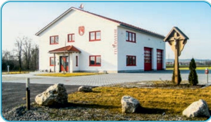
Bau des Feuerwehrhauses Feldgeding
