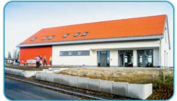
Bau Bürgerhaus Deutenhausen
