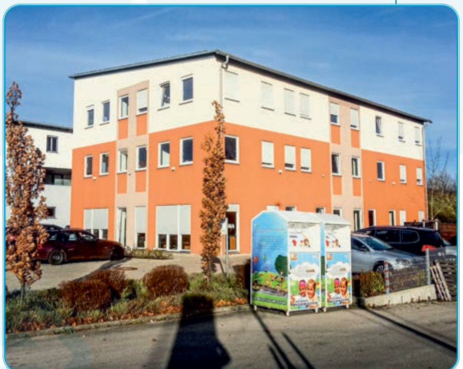
Fertigstellung Gewerbebau Günding
