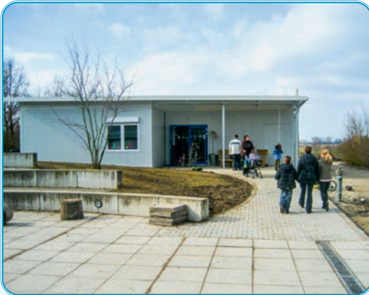
Eulenhof 1. Bauabschnitt fertiggestellt
