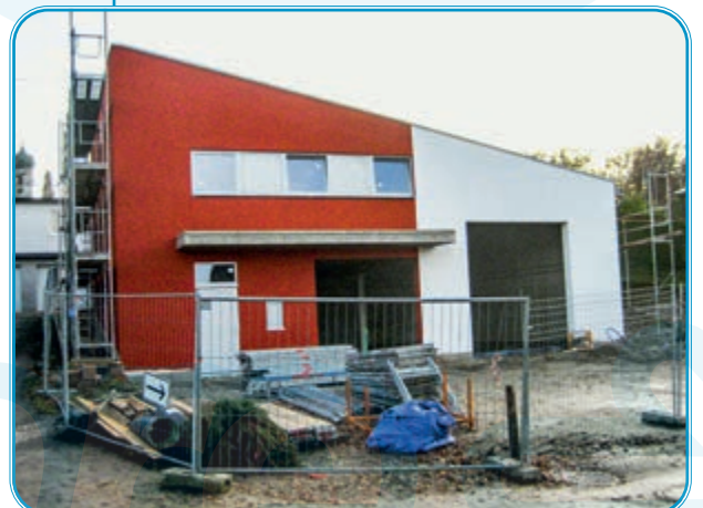
Bau Feuerwehrhaus Lauterbach
