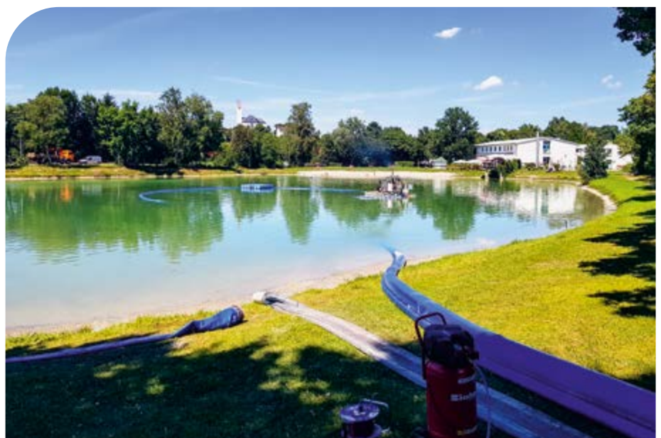
Entschlammung des Badesees Bergkirchen
