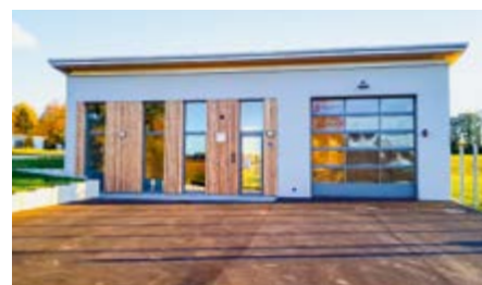
Das neue Feuerwehrhaus in Bergkirchen ist fast fertig Foto: JG
