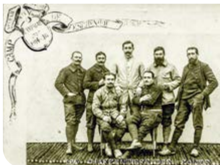
Die Zimmerleute der Brücken
