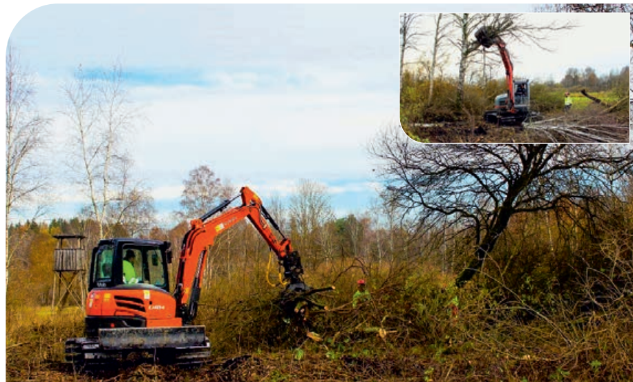
Rodungsarbeiten im Fußbergmoos. Um den Abtransport vorzubereiten wird das Holz von Baggern mit speziellen Moorketten zur Seite gelegt
