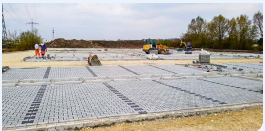
Die Pflasterarbeiten am neuen P+M-Platz sind mittlerweile abgeschlossen
