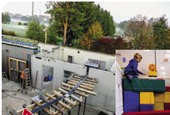
Die Baustelle draußen ...
