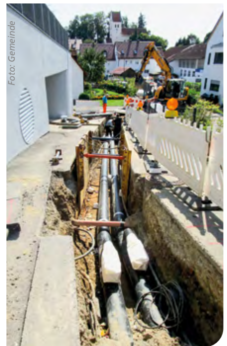
Fernwärmeausbau in Günding
