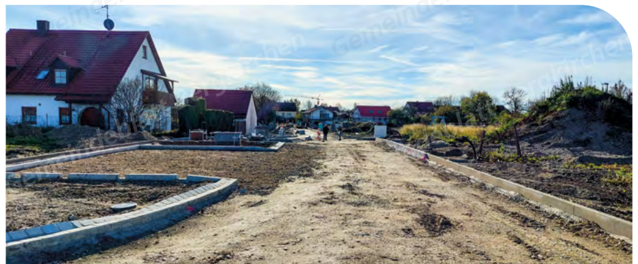
Die Längenmoosstraße in Unterbachern wurde komplett saniert. Dabei wurde der Unterbau und die Regenentwässerung völlig erneuert. Foto: JG
