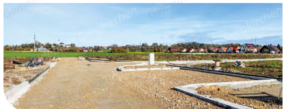
Die Erschließung des Baugebietes in Feldgeding, Steinfeldring ist nahezu abgeschlossen. Der Spielplatz ist fast fertig und demnächst wird die erste Teerschicht aufgebracht. Fotos: JG
