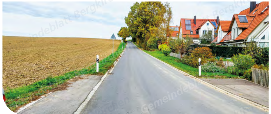
Die Längenmoosstraße in Unterbachern wurde komplett saniert. Dabei wurde der Unterbau und die Regenentwässerung völlig erneuert. Foto: JG
