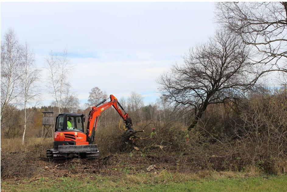
Bild (Auswahl): Rodungsarbeiten im Fußbergmoos. Um den Abtransport vorzubereiten wird das Holz von Baggern mit speziellen Moorketten zu Seite gelegt (Foto A. Fuchs)
